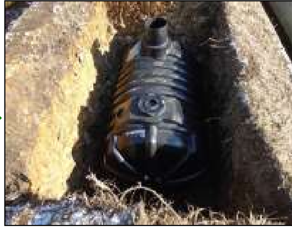
集水タンク敷設
