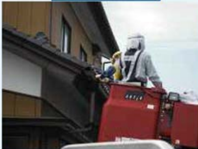
宅地除染(雨樋拭き取り)
