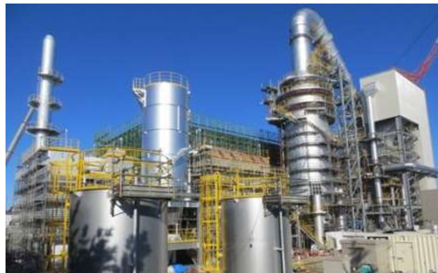
南相馬市における仮設焼却施設の建設状況 (2015年2月)
