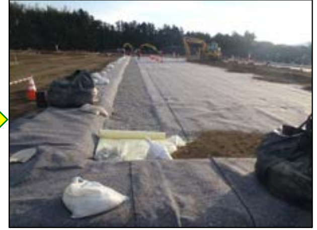
底部シート敷設
