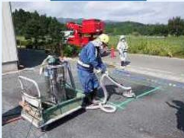
宅地除染(高圧水洗浄)
